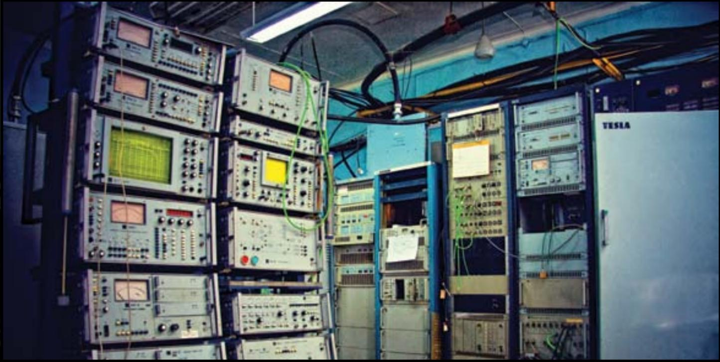
Это передатчики – говоря простым языком, они усиливают получаемый сигнал и затем передают его на антенны жителей КМВ. Внутри вышки есть специальная лестница, по которой инженеры-ремонтники поднимаются наверх. На самой вышке находятся мощные излучатели. Поэтому прежде чем подниматься наверх, нужно отключить все антенны.
