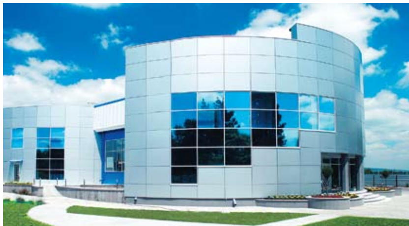
Производственное здание г. Ессентуки. Навесной вентилируемый фасад, алюминий, стекло.
